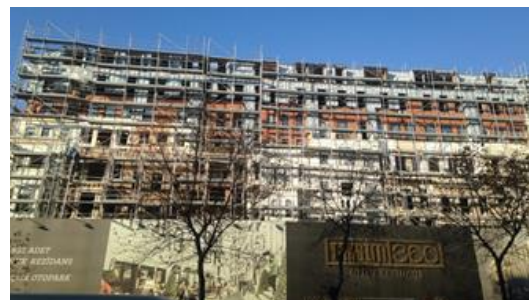
Figure 5: Tarlabası 360 Project on site.
