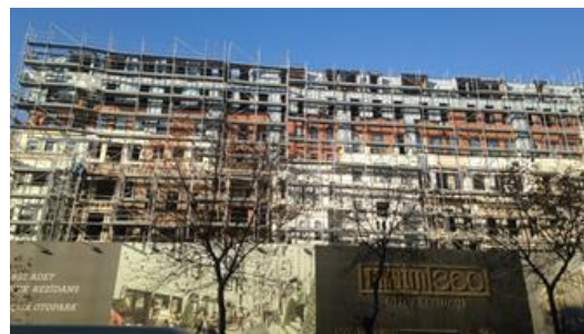
Figure 5: Tarlabası 360 Project on site.
